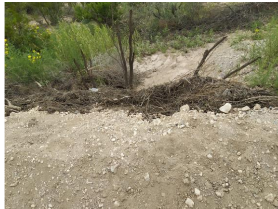
Barreras de material seco para reducir la erosión de los suelos por acción del agua en El Tepetate.
