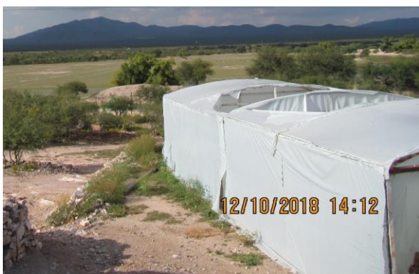
Invernadero para producción de forraje hidropónico deteriorado (Huertecillas)
