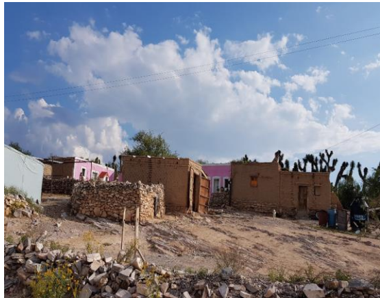
Construcciones de piedra y de adobe en Huertecillas
