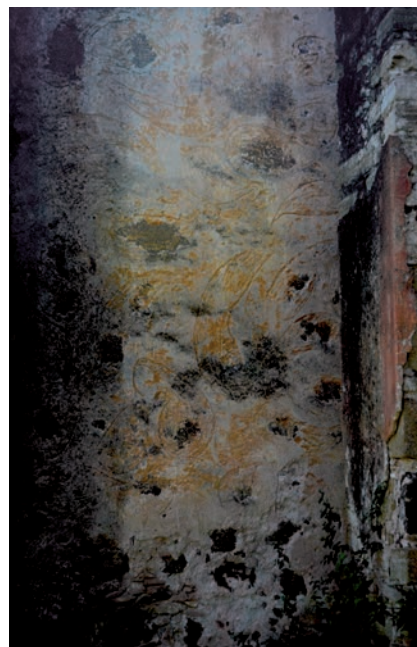
5. Esgrafiado de lágrima en la torre de la iglesia de Pozo del Carmen. Foto del autor, 2013.
