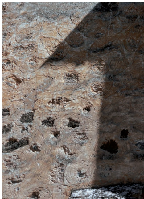
4. Esgrafiado de lágrima en el muro norte de la iglesia de Pozo del Carmen. Foto del autor, 2013.
