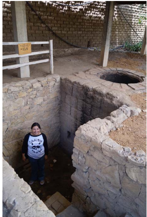
Figura 45.- Forma del horno para quemar las piezas cerámicas de barro negro que se encuentra en el taller alfarero de Doña Rosa. Fotografía de Luis López –alfarero del taller–, San Bartolo Coyotepec, Oaxaca (agosto de 2016).
