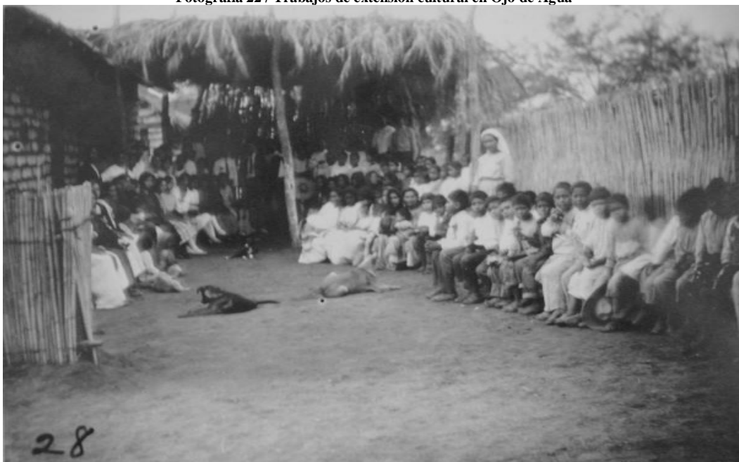
Fotografía 22 / Trabajos de extensión cultural en Ojo de Agua
