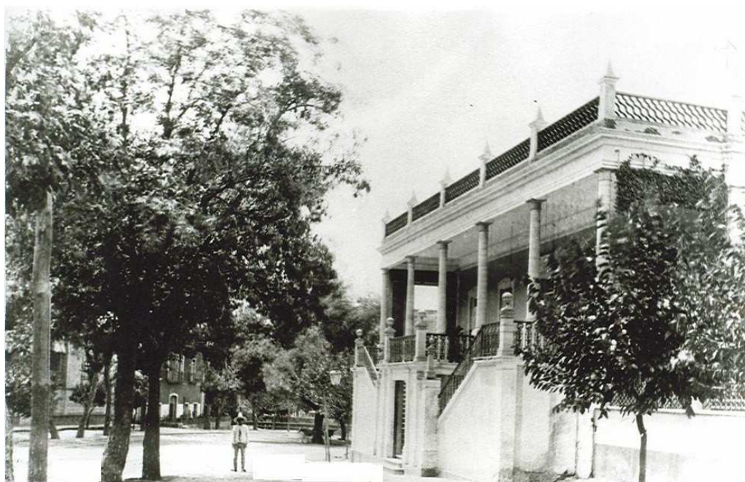
Casa de Gregorio Jiménez y Antonia del Moral en el Paseo de la Presa de la Olla Fuente: Fototeca del AGEF
