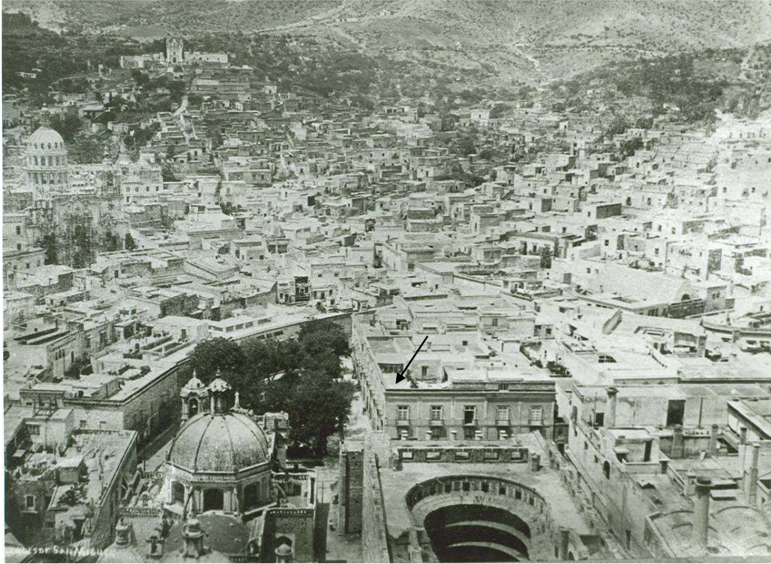
Casa heredada por los descendientes de Marcelino Rocha a la derecha del Jardín Unión. En primer plano la iglesia de San Diego, el Teatro Juárez en construcción y en seguida se observan las chimeneas de la Casa de Moneda. Fuente: Fototeca del AGEG.
