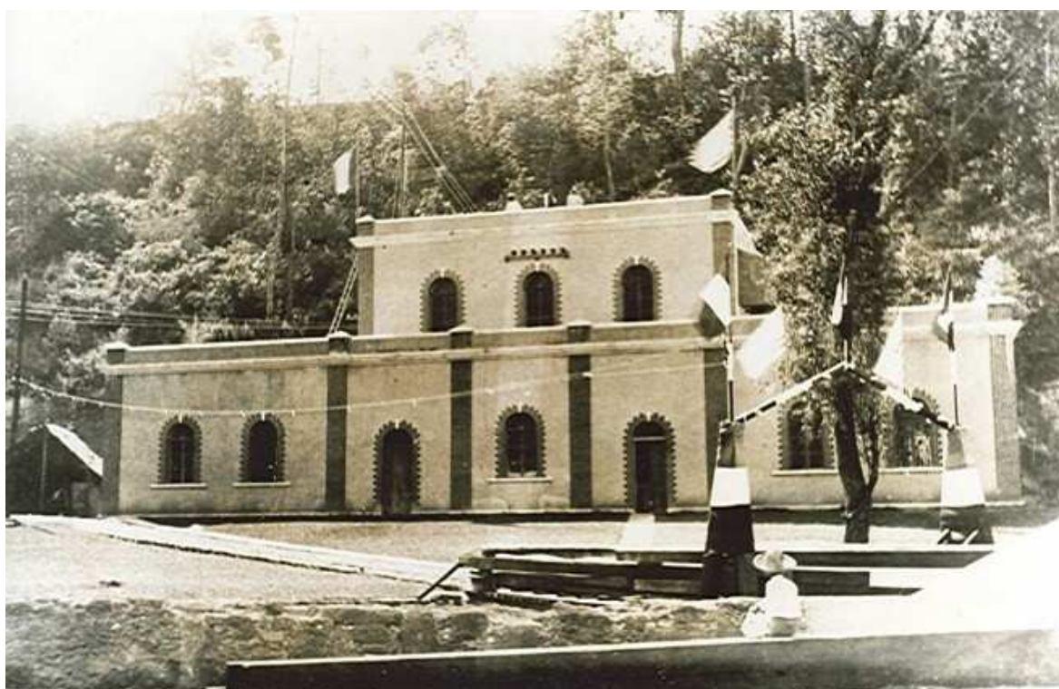
Planta de electricidad ubicada en Pastita Fuente: Fototeca del AGEF
