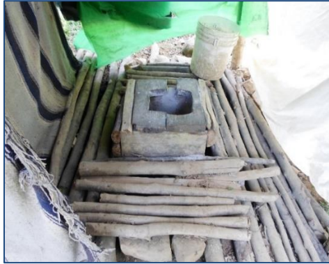
Interior de letrina, Coamízatl
