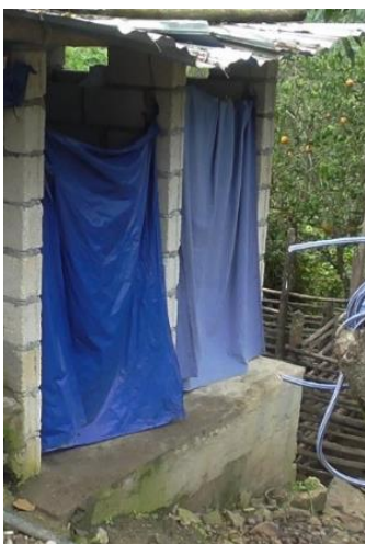
Cámaras de sanitario seco, Cacalacayo
