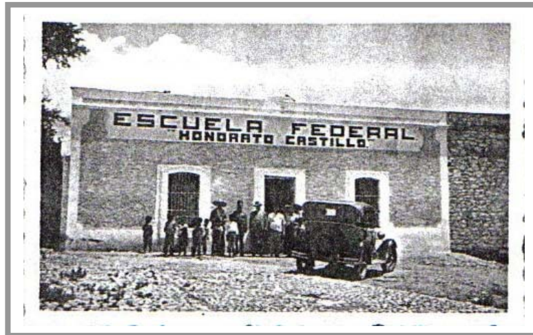
Imagen 7. Edificio Principal de la Escuela de Pozo de Acuña, Municipio de Guadalcázar, San Luis Potosí, mayo de 1934. Fuente: AHSEP, Caja 117, año 1934, expediente 101, folios 17.
