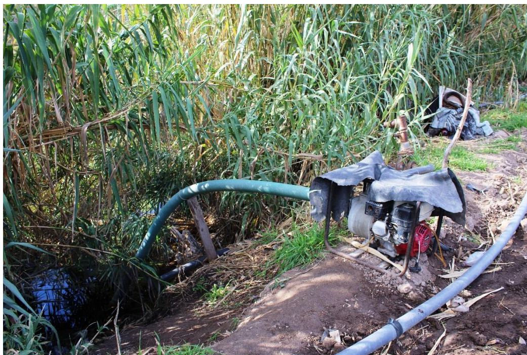
Foto.21. Motobomba instalada a las orillas del río Mexquitic, como riego Directo del Río.
