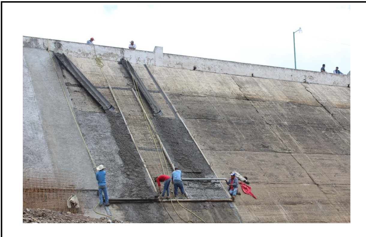
Foto.6. Reparaciones a la cortina de la Presa Álvaro Obregón, 2016.
