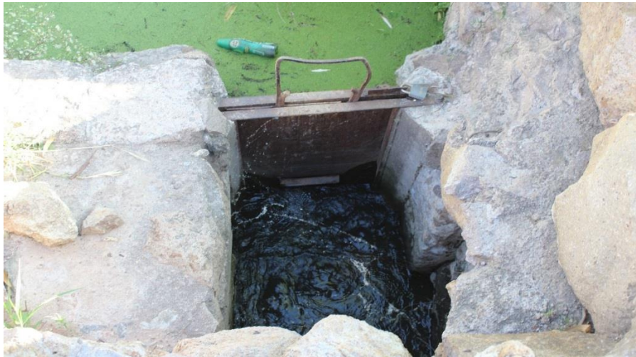
Foto. 27. Conjunto de fotografías de la compuerta del sistema de riego “La Canaleta”.
