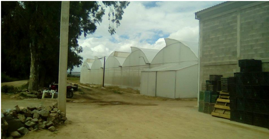
Figura 35. Invernaderos pozo ocho. Fotografía. Daniela Estrada, agosto 2016.
