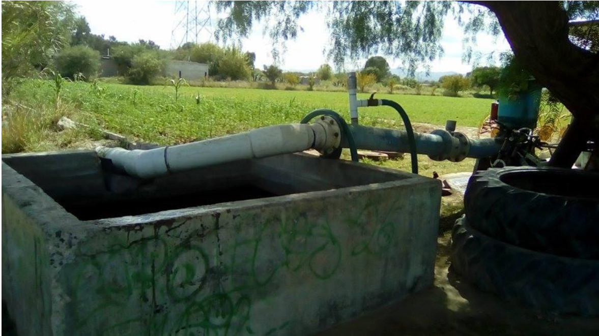
Figura 27. Instalaciones del pozo cuatro.
