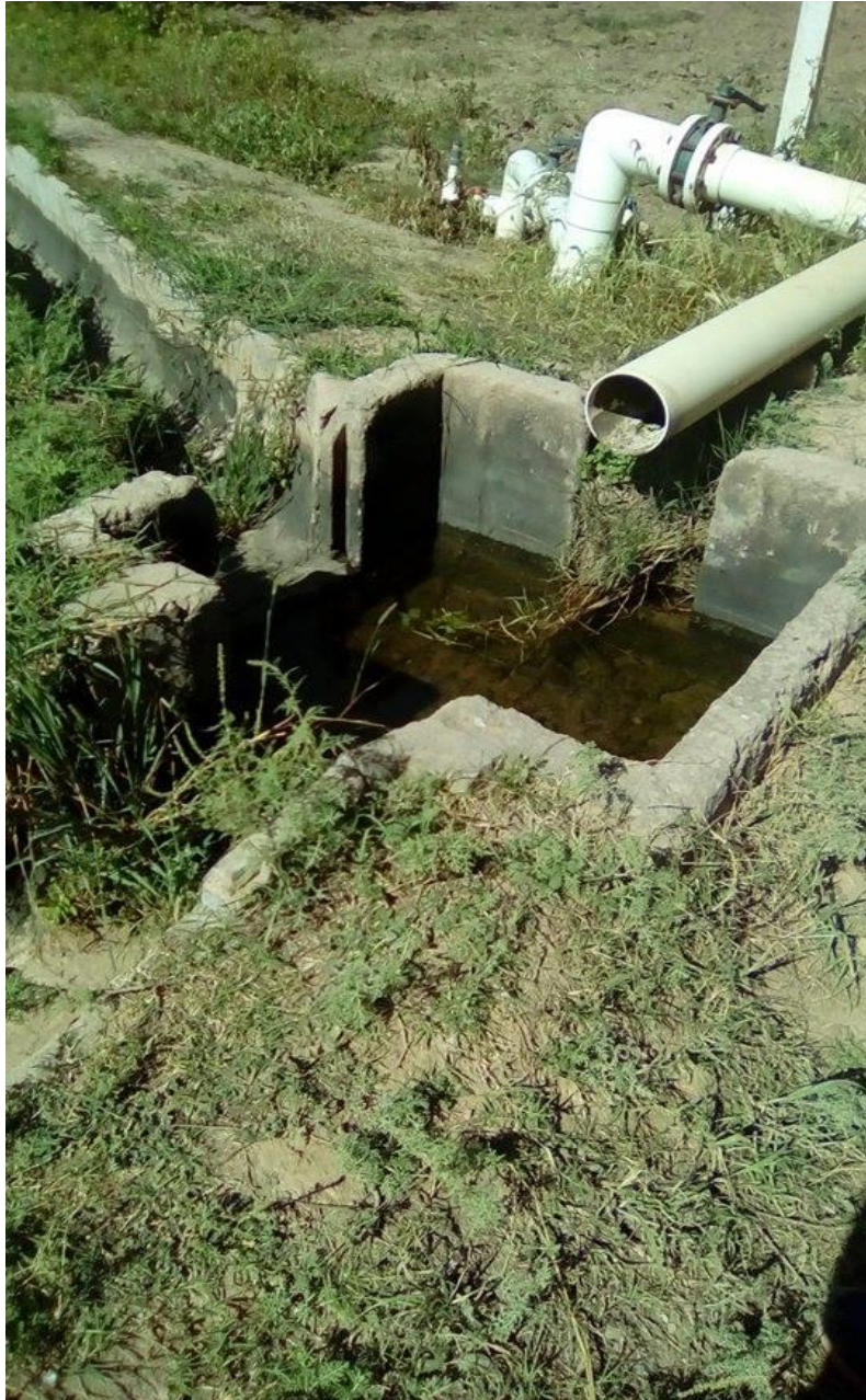
Figura 23. Tomas conectadas con el pozo. Cada uno de los socios se encarga del mantenimiento de sus conductos.
