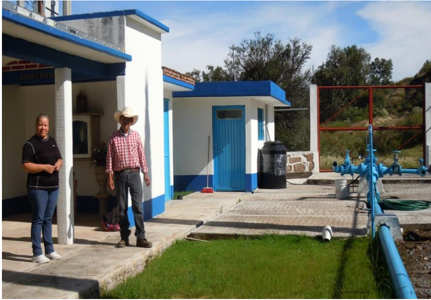
Imagen 20. Trabajadores del SAPZ en las instalaciones del pozo de agua potable. Administradora del sistema (Isabel Sánchez) y el fontanero (Melitón Hernández). Fotografía: Alma Barranco, 2016.
