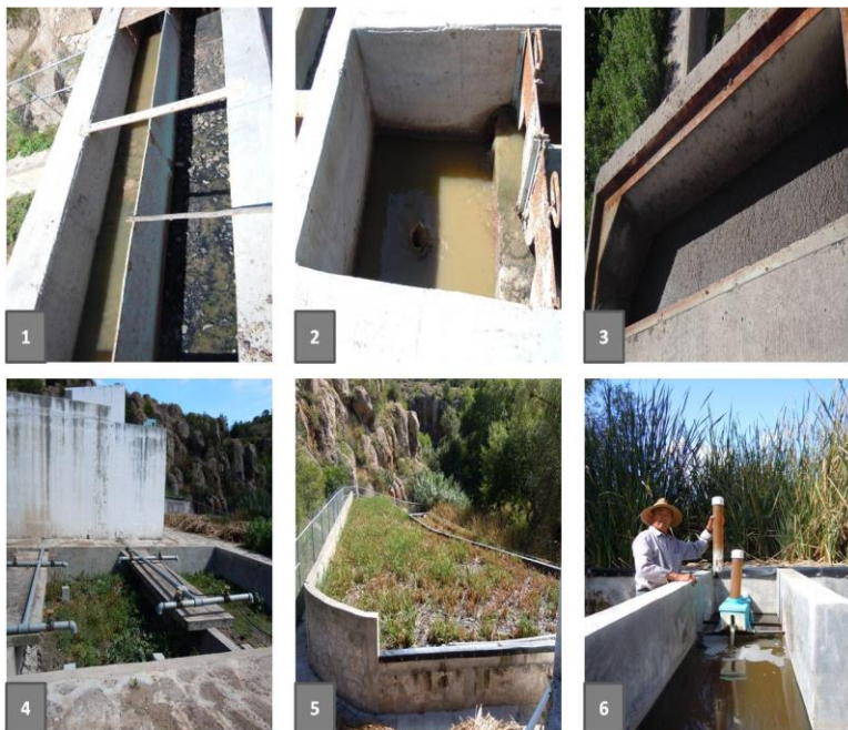
Imagen 22. Funcionamiento de la planta tratadora de aguas negras de Zothé. 1. Pre tratamiento del agua (retiro de basura), 2. Filtración de lodo, 3. Lodos, 4. Deposito de secado de lodos, 5. Terrazas de filtración, 6. Desinfección del agua tratada. Fotografías: Alma Barranco, 2016.
