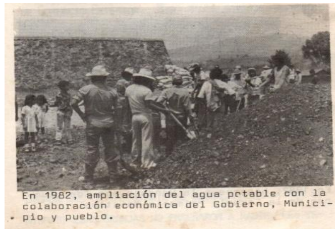
Ilustración 19. Construcción del tanque II. Fotografía de Chávez Carmona & López Becerril, 1982:19.
