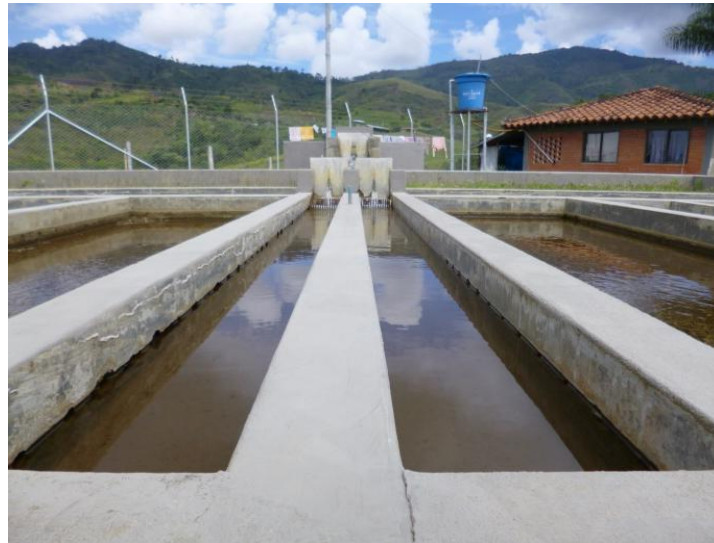
Ilustración 33. Entrada a planta FiME y 1er Filtro Grueso Dinámico. Fotografía de Molina, 2014.
