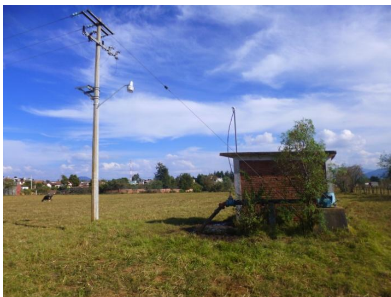
Ilustración 20. Pozo "El Llano". Actualmente se encuentra en desuso. Fotografía de Molina, 2015.
