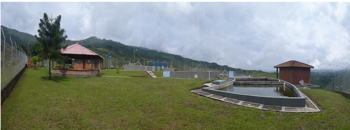
Ilustración 34. Panorámica de instalaciones de la planta FiME. Fotografía de Molina, 2014.
