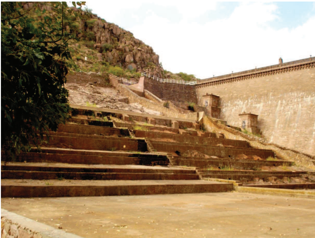
Foto 1. Presa de San José, cuyas obras de construcción concluyeron en el año 1903. Robledo Carmona, 2012.
