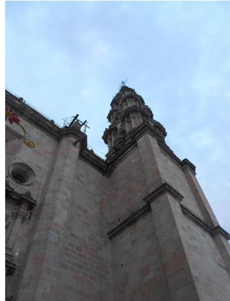
Muro exterior en sillería de cantera.
