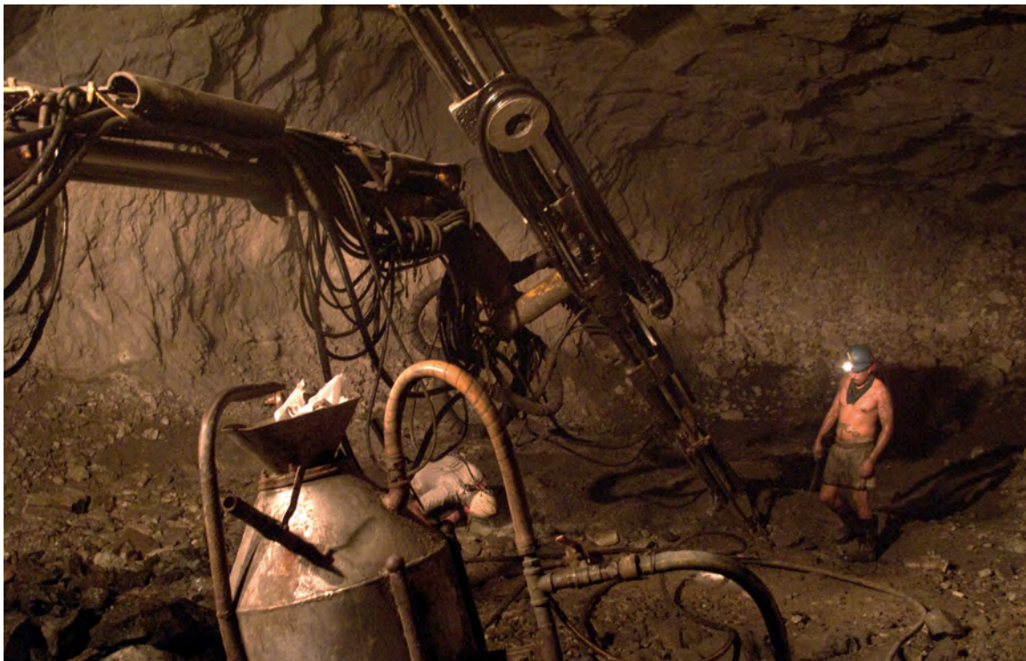
Imagen 46. Ayudantes de jumbero guiando unos barrenos de piso, julio de 2011.
