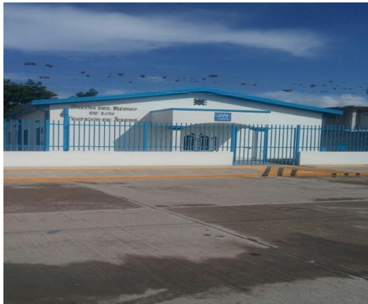
Figura No. 13. Fotografía de la fachada del Salón del Reino de los Testigos de Jehová.
