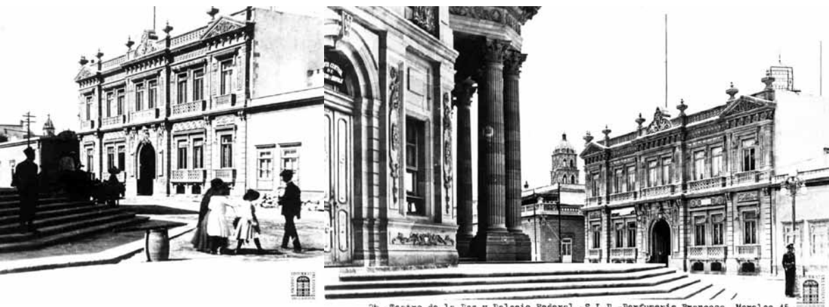
A la izquierda: Fachada principal del Palacio Federal o Edificio Martí, vista desde el costado norte del Teatro de la Paz, ca. 1905. AHESLP. A la derecha: Vista de uno de los costados del Teatro de la Paz y fachada del Palacio Federal, al fondo la torre del templo de San Agustín, ca. 1950. AHESLP.
