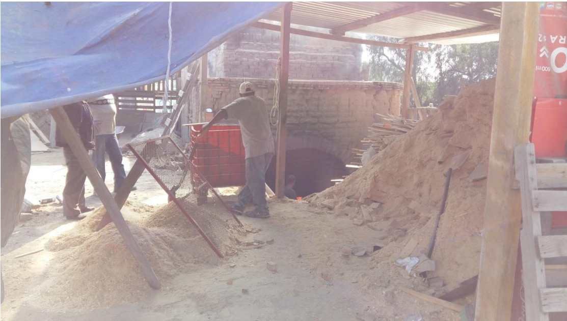
Fotografía 17. Hornos estándar con soplador. Fotografía Lic. Joaquín Valenciano Reyes (Fotografía recuperada del proyecto: “Diagnostico socioambiental sobre las ladrilleras en la zona metropolitana de San Luis Potosí y Soledad de Graciano Sánchez” (2019)
