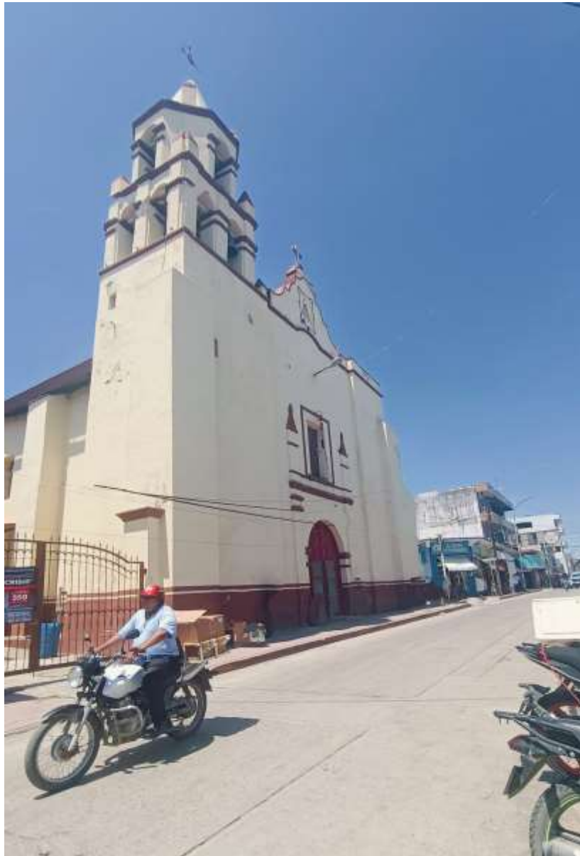
Imagen 3: Parroquia de Santiago de los Valles. Fue construida en 1593 como se conserva hoy en día, después de haber sufrido dos incendios en 1534 y 1590. Fuente: archivo personal, 2022
