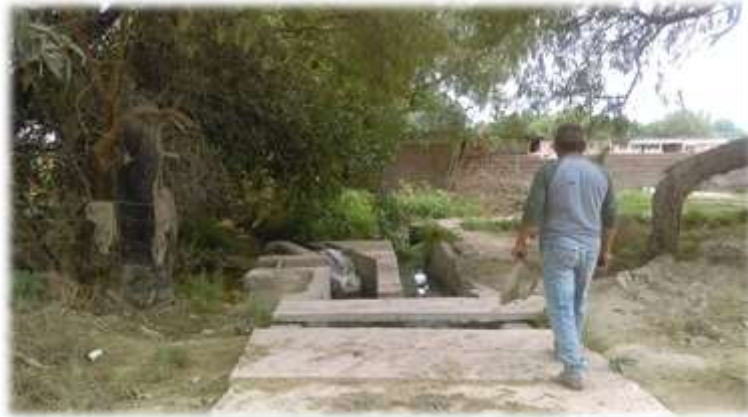
Foto 14. Tomada el 05/04/2019 por Rebeca Arellano Moctezuma: Canal 4 (Ramal Santa María) sirve al ejido de Soledad para el riego de sus terrenos, pero presenta pavimentación para evitar contaminación y mal olor.
