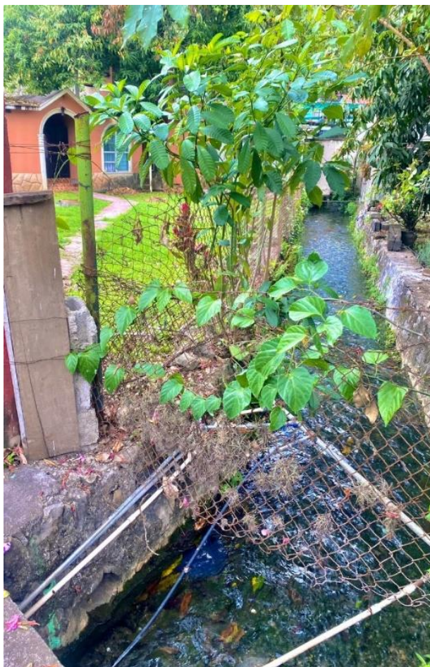
Ilustración 11. "La sequia" canal de drenaje en Agua Buena. Marzo 2023.
