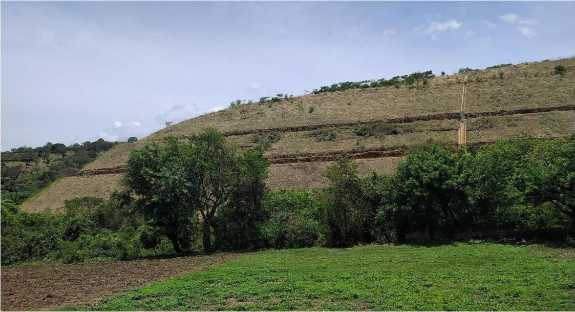
Imagen 14. Presas de jales de El Fraile durante la estación lluviosa (julio 2021). Fuente: Flores: (2021).
