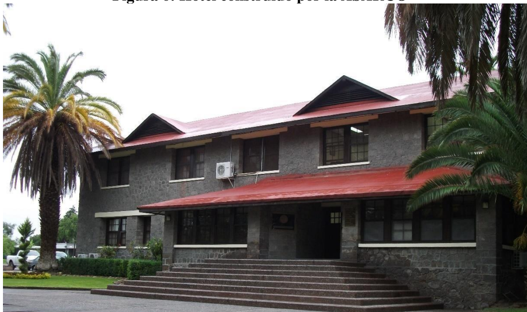
Figura 6: Hotel construido por la ASARCO
