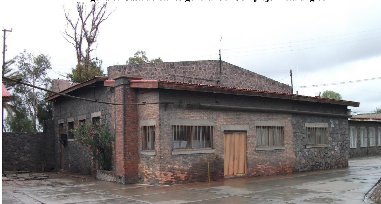
Figura 8: Casa de baños general del Complejo metalúrgico
