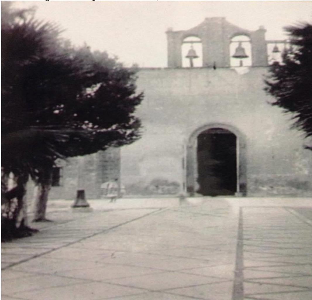
Figura 14: Capilla de Morales, antes de las obras de renovación
