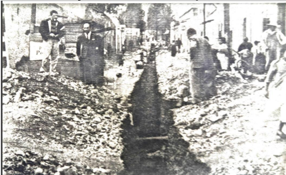
Figura 12: Salvador Nava supervisando las obras de drenaje en Fracción de Morales
