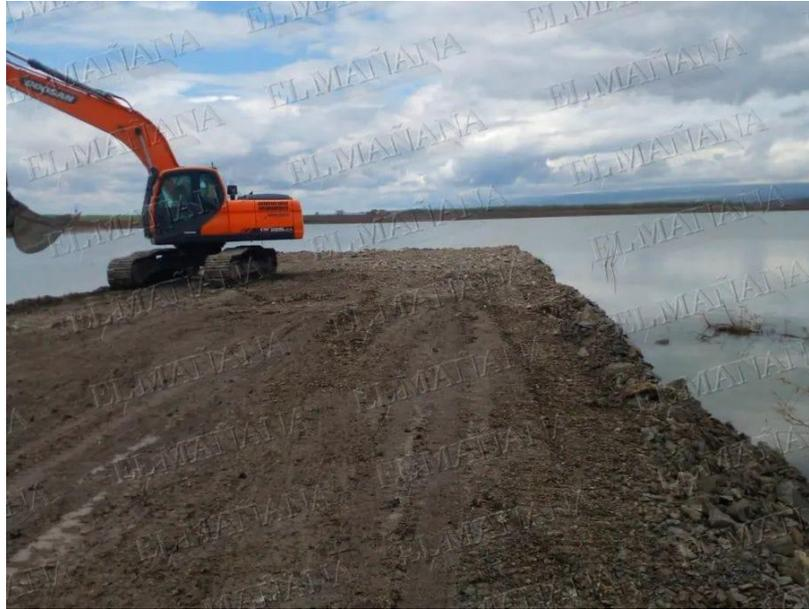
**Figura 22.** Maquinaria dentro de la presa La Lajilla realizando una excavación más profunda para obtener mayor cantidad de agua. *Fuente:* El Mañana de Valles (27 de abril 2022).
