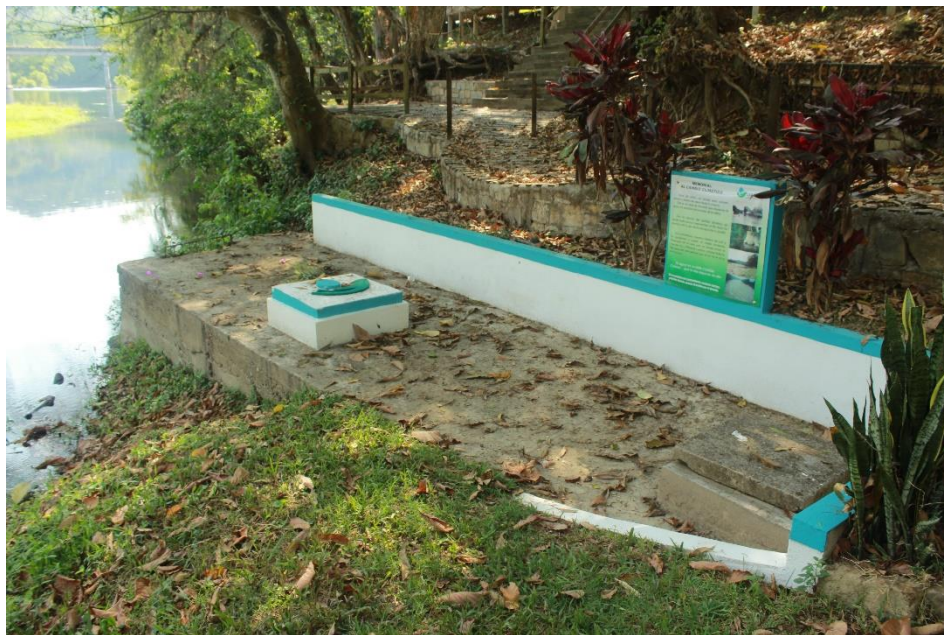
Ilustración 43: Boca toma del río hacia el sistema de agua potable de Axtla de Terrazas.
