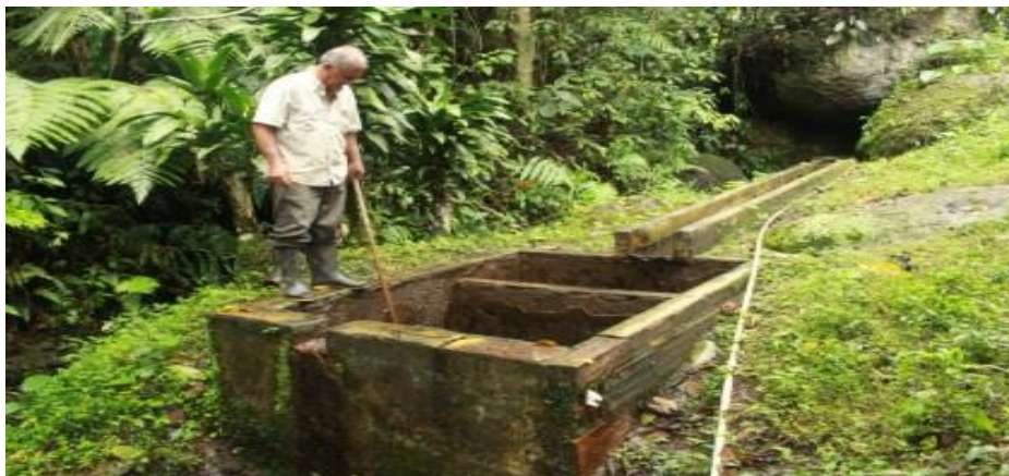
Ilustración 18: Lavado bocatoma sector San Judas
