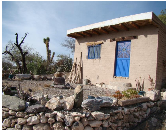
Fotografía 24.- Cuarto de curaciones y estudio de Pierre-Henry. Santa Cruz de Carretas, S.L.P., 2013. Autoría personal.
