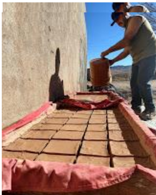
FIGURA 23. COLADO DE BARRO ROSA, FOTOGRAFÍA: CARMEN GRAJEDA, LUGAR: MATA ORTIZ, FECHA: MARZO DE 2019.
